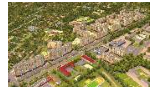
ЖК «Петровский», Свердловская область «Элит-групп»
