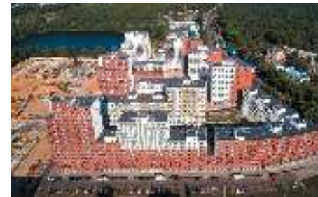
ЖК «Новокрасово», МО «Тройка РЭД»
